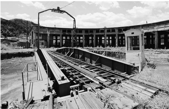
【写真12】1930年製の転車台と、1954年製の電動牽引機
