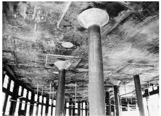
【写真8】天井を支える柱・ハンチと排煙筒跡
