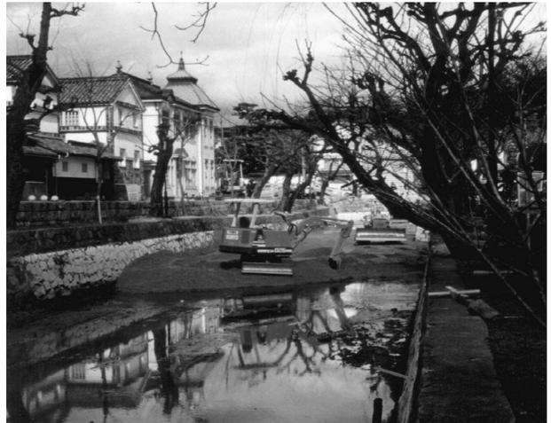
写真1. トラクターでのヘドロの搬出と白砂搬入
