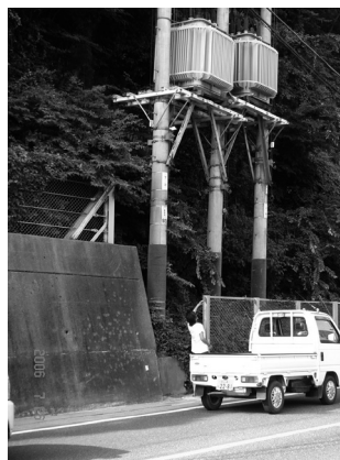
図15. 地点No.17の周辺状況
