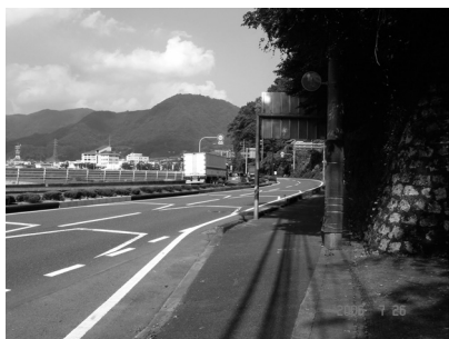
図12. 地点No. 3の周辺状況
