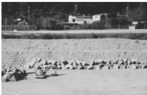
写真4. 改修工事で掘り出された岩石 (高梁川落合橋上流部)
